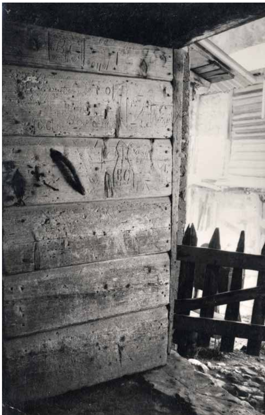
Fig. 15. Località Agaón (Mezzano). Battente della porta di una stalla trasformato in palinsesto scrittore (foto Pietro Gilli, archivio eredi Gilli).
