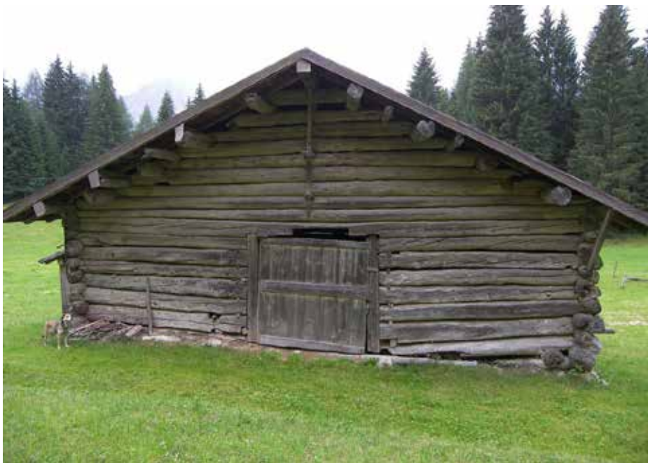
Fig. 14. Località Combai (Mezzano). Porta del fienile con l'architrave tagliato: un fenomeno abbastanza diffuso negli edifici in blockbau (foto archivio Comunità di Primiero).
