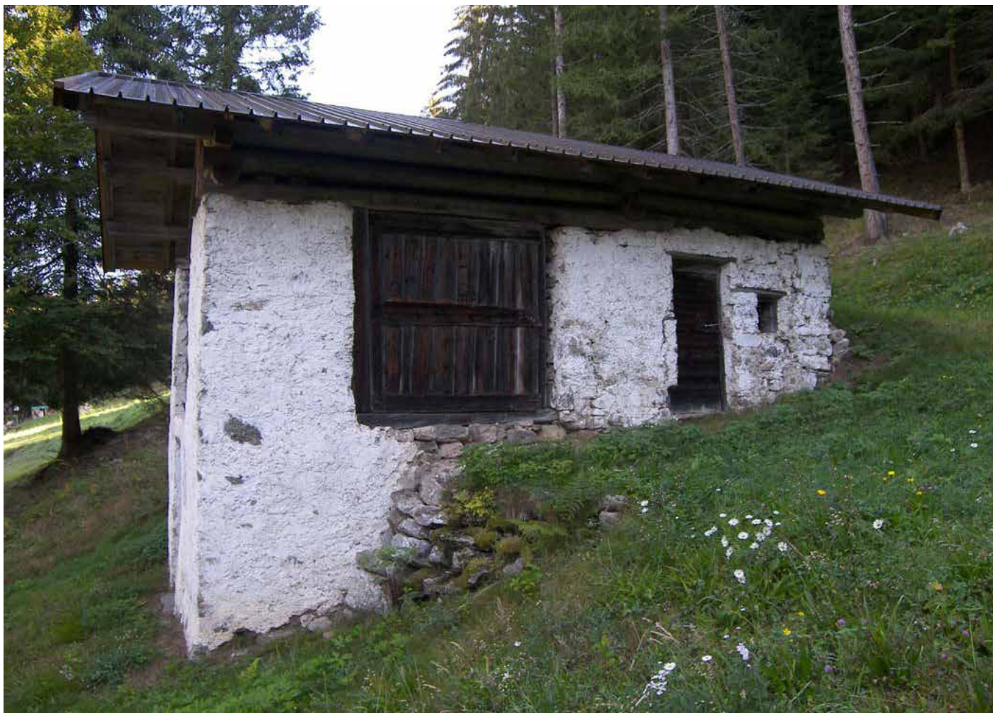
Fig. 6. Edificio tipo A.3 in Valle del Lozen (Mezzano). Foto archivio Comunità di Primiero.
