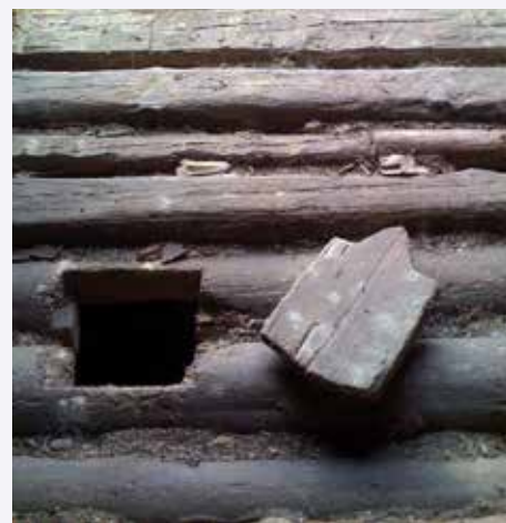
Piccolo "bus del fenèr", ricavato nel pavimento del fienile, col suo coperchio.
