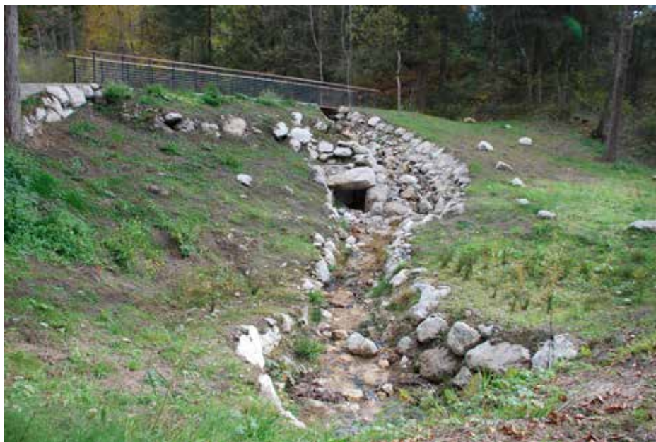
Fig. 41. Rampa in pietrame (Foto: C. A. Turra).
