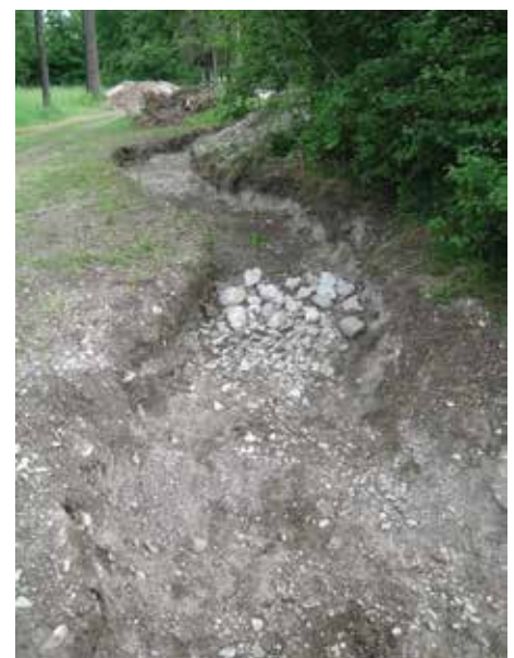
Fig. 5. Microambiente di riffle realizzato nel tratto corrispondente a quello di fig. 2.
