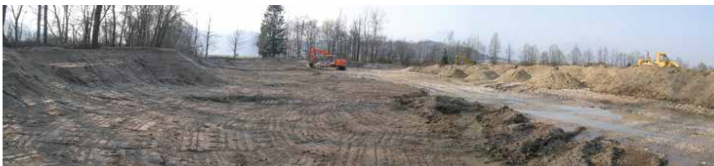
Fig. 13. Panoramica del lago da Est ad Ovest nella fase di asportazione del materiale grossolano; sullo sfondo è visibile il viale degli Olmi, oltre il quale è stata realizzata l'altra porzione del lago.
