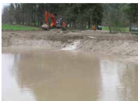
Fig. 15. Due fasi del riempimento del lago alimentato da una deviazione di portata del Rio Caoramello.
