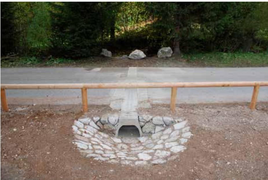
dello stesso rivo sotto la strada comunale, attraverso una tubazione e un ulteriore salto, non superabili dalla maggior parte della fauna acquatica. Si è proceduto pertanto alla realizzazione di una rampa in pietrame e di un sottopasso stradale con caratteristiche tali da ripristinarne la funzionalità (fig. 41).
